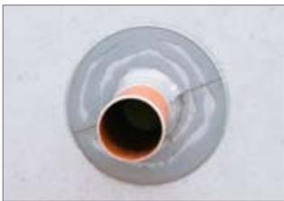
PIPE-SHELL<sup>2</sup> Dichtflansch als **Wanddurchführung**
